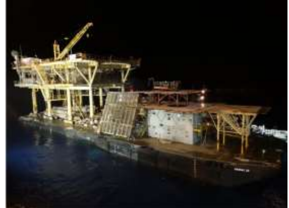
Deck e várias estruturas do Topsides na balsa de transporte
