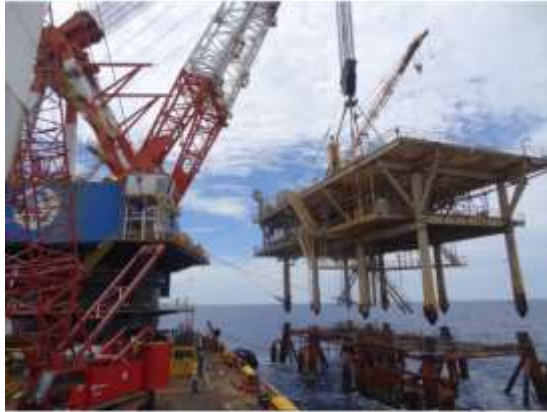
Deck cortado e pronto para colocação na balsa de transporte
