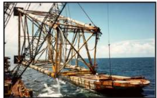
Remoção da Jaqueta p/ Transporte
