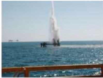
Corte de Estacas com Explosivos
