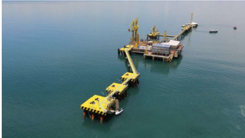
Terminal de Regaseificação da Bahia (BA), arrendado pela Petrobras em 2021 para a Excelerate Energy (Foto: Petrobras)
