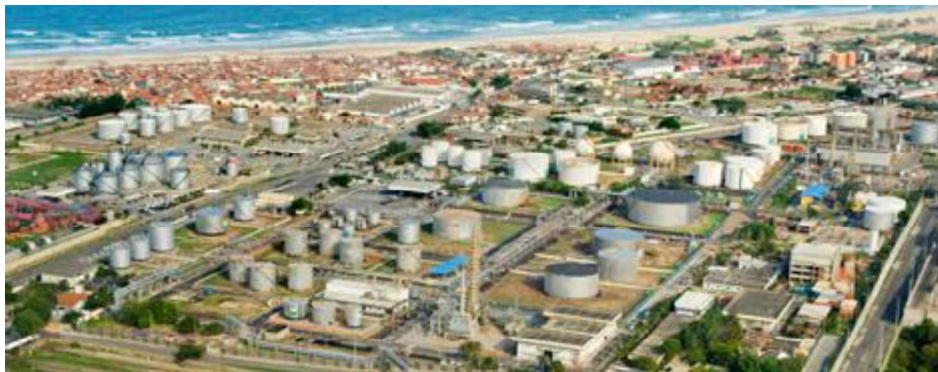
Unidade de Lubrificantes e Derivados do Nordeste – LUBNOR Foto: Petrobras
